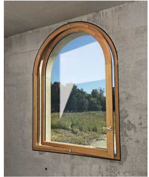
In Haus 3 kommen die dicken Wände aus Leichtbeton ohne Stahlbewehrung aus
