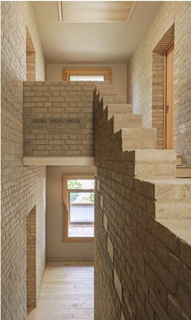
Das Treppenhaus von Haus 4 besteht aus Lehm und Holz. Auf teure Lüftungstechnik wird verzichtet
